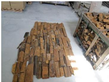
**02)** Antes de iniciar a colocação deve-se **montar um painel no chão** (1 à 2 m<sup>2</sup>), na qual permitirá uma prévia visualização de como ficará assentado na parede.
